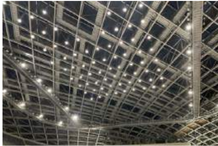
杭州奥体中心
